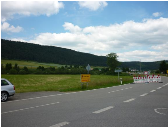
Bild: Zustand vor dem Umbau
