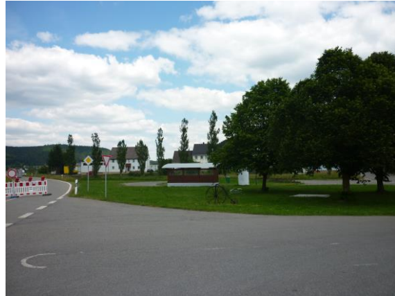
Bild: Zustand vor dem Umbau
